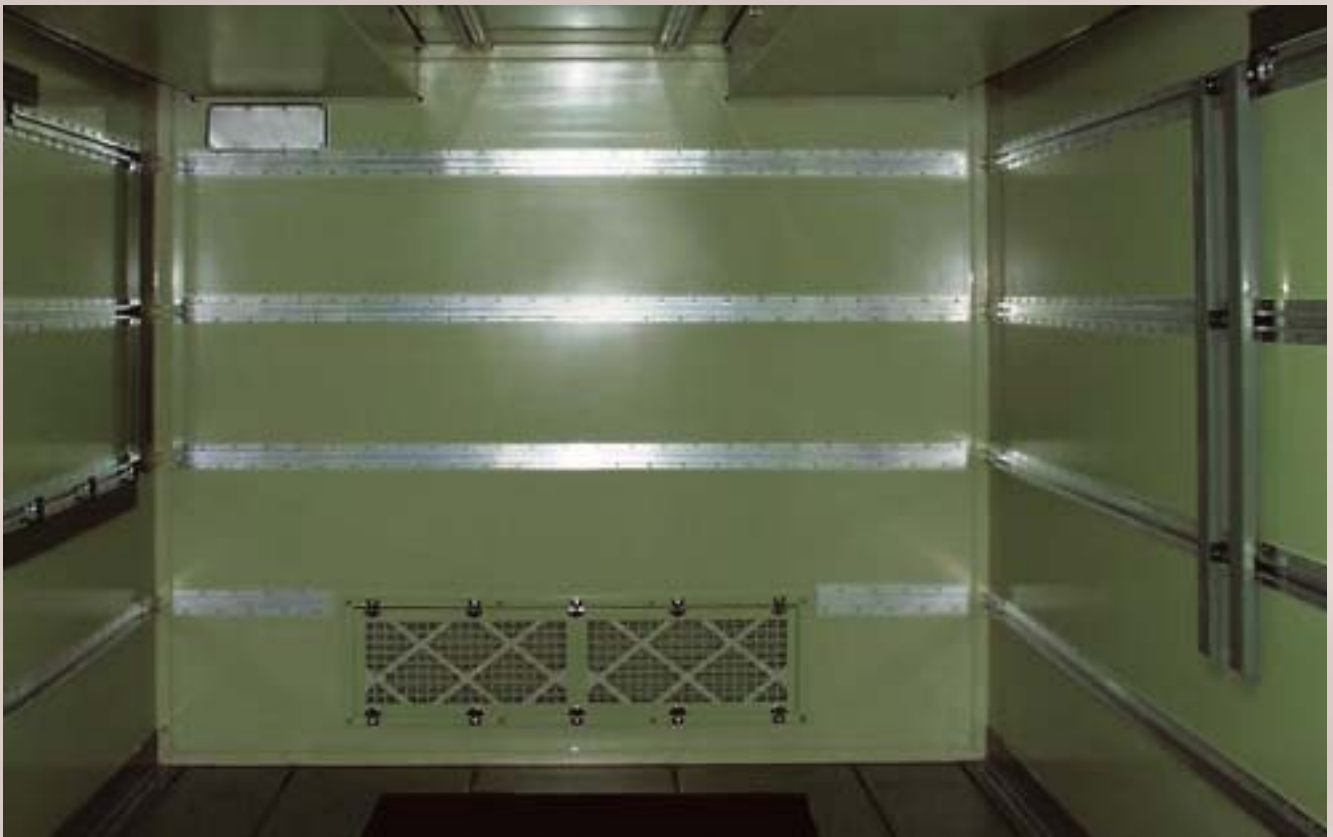
Innenansicht mit Rückluftfilter und Luftverteilsystem (oben)
